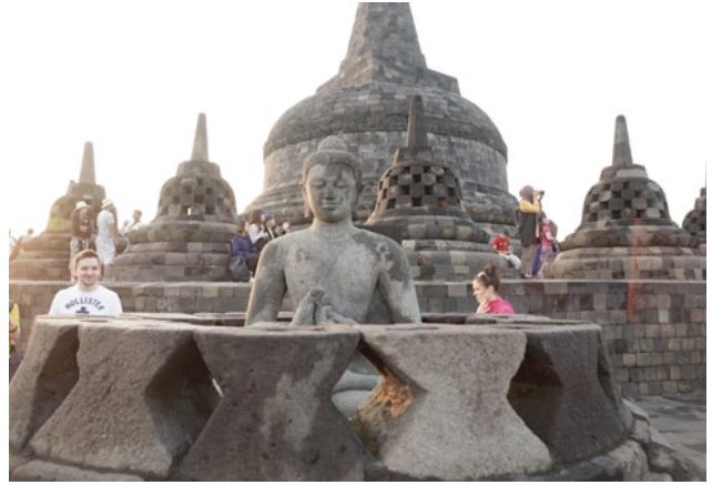
ボロブドゥール・目透かし格子が破壊されたストゥーパ (内部の仏像が露出)
