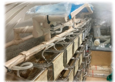
写真2 自動給水システム
