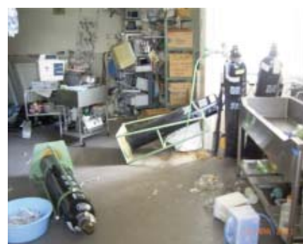
手術室は壊滅。ボンベは壁等に固定されていなかったため転倒した。
