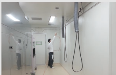
写真6. 光触媒コーティング作業の様子
